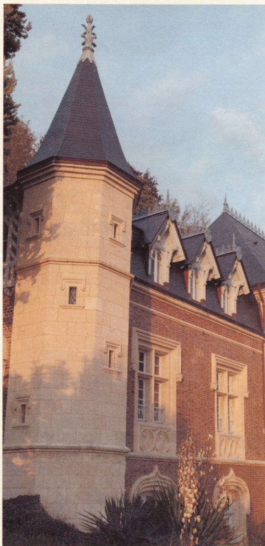
Photo façade Manoir : Joerg Lehmann.
